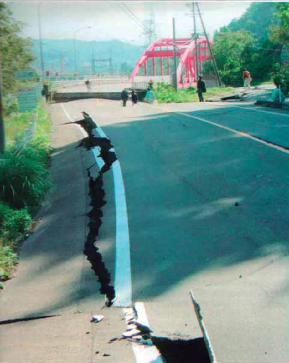
Un movimiento telúrico provoca la aparición de inmensas grietas que llegan a destruir el asfalto.
