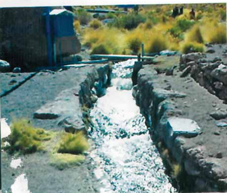
94 vertientes de agua potable, colectadas por medio de canaletas construidas de cal y piedra vacían el agua a un canal central.
